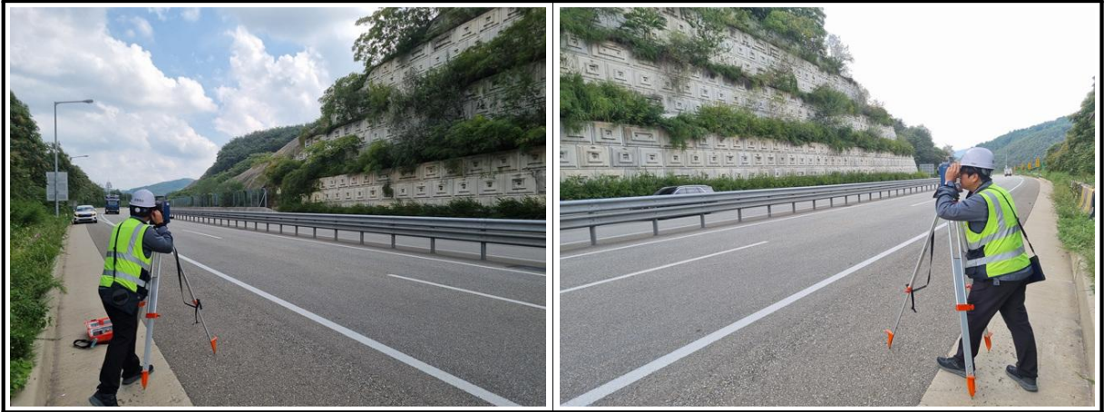
【사진 5.4.2】 측량작업 전경
