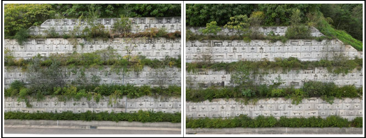
【사진 5.3.2】전면부 전경
