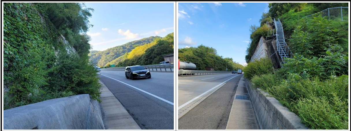
【사진 5.3.1】 지반, 기초부 전경
