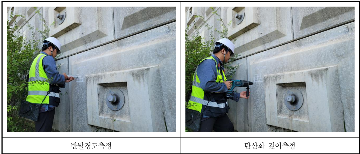
【사진 5.4.1】 재료시험 조사 전경
