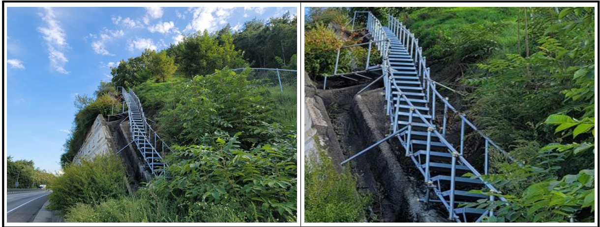
【사진 5.3.4】 옹벽 점검시설 전경
